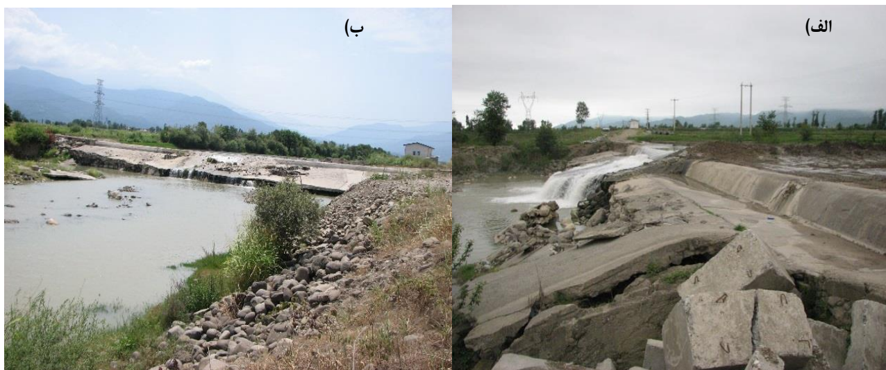
شکل ۱. تصاویری از افت تدریجی بستر رودخانه در پایین دست سازه کنترل تراز بستر سطح شیب دار در رودخانه پلرود استان گیلان، الف) سال ۱۳۹۰ و ب) سال ۱۳۹۸
