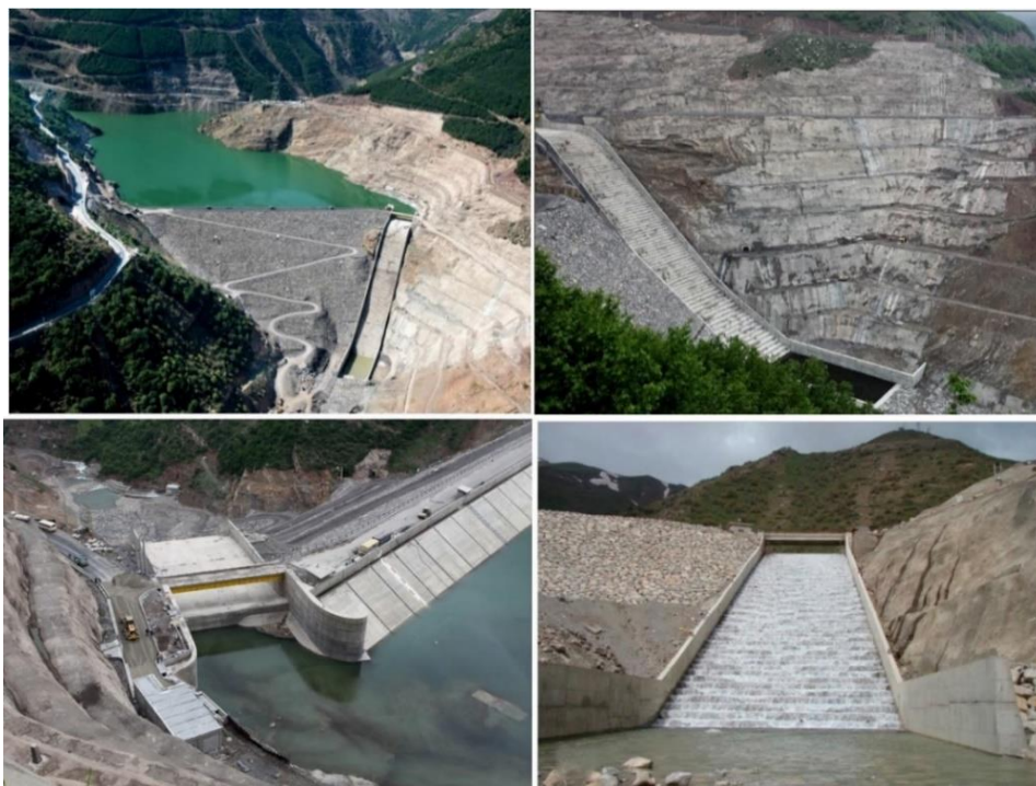
شکل ۵- نمایی از سرریز پلکانی سد سیاه‌بیشه بالا
