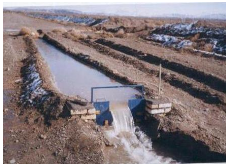
شکل ۷- نمایی از شروع کانال مسیر ۱
