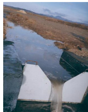
شکل ۹- سرریز مثلثی بر روی کانال مسیر ۲
