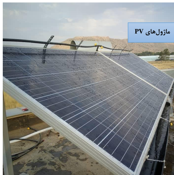
شکل ۱- نمایی از سامانه PV-RO ساخته شده و اجزای آن
