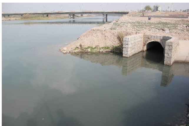
شکل ۳- فاضلاب شهری ورودی به رودخانه دز پایین دست پل پنجم
