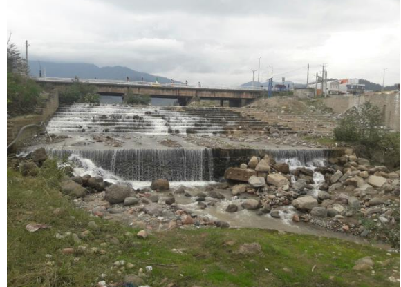
شکل ۱. نمایی از سازه‌های کنترل تراز بستر سرریزهای پلکانی در رودخانه لیسار استان گیلان
