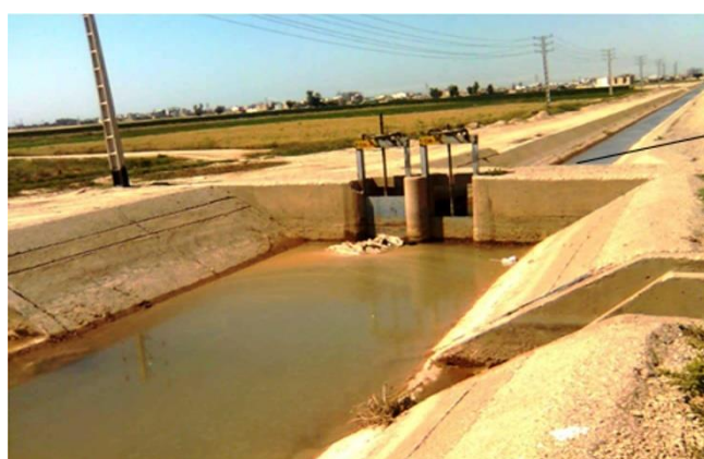
شکل ۲. نمایی از کانال E1R1 و سازه‌های آب‌بند و آبیگر موجود در آن
