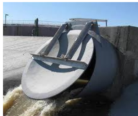
شکل ۳- نمونه دریچه آویخته با مقطع دایره‌ای در انتهای یک مجرا
