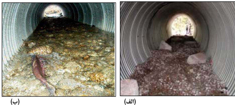
شکل ۳- نمونه‌های کاربرد عملی مجاری دایره‌ای رسوبگذار در طبیعت، (الف) آماده‌سازی کالورت، (ب) بهره‌برداری از کالورت
