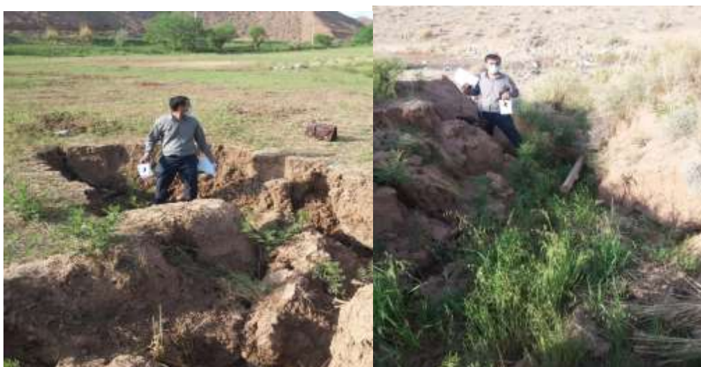
شکل ۲. نمایی از خندق‌های مشاهده شده
